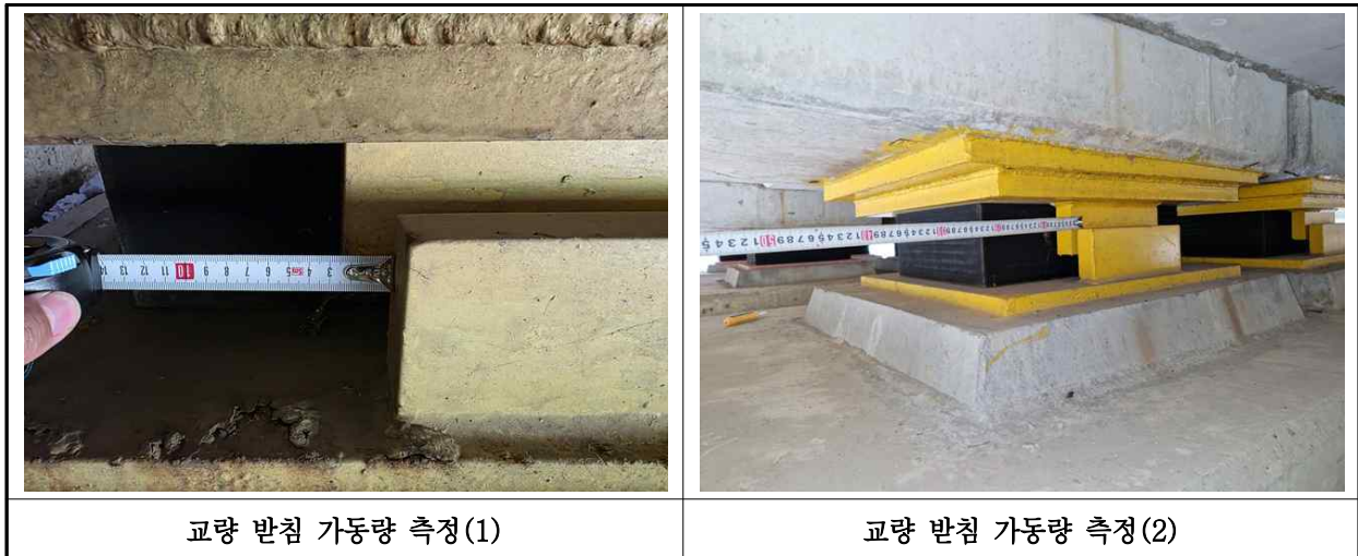
【사진 10.3.16】 교량받침 이동량 측정
