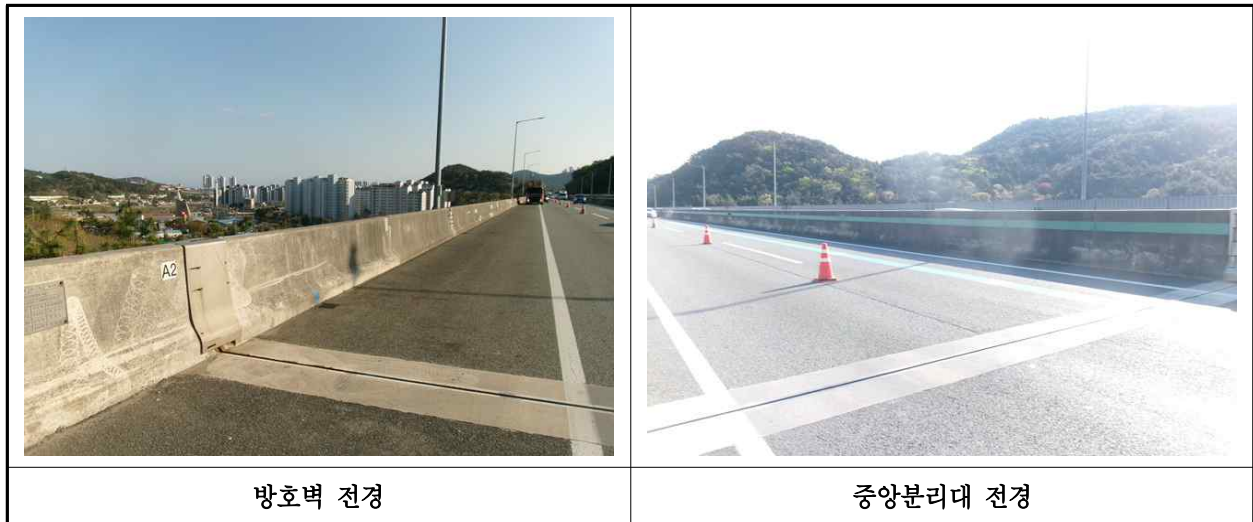
【사진 10.3.24】 방호벽 및 중분대 전경
