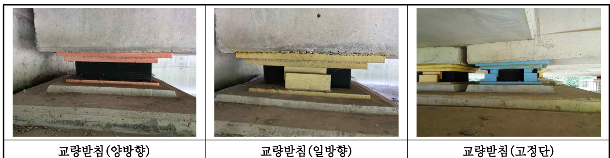
【사진 10.3.13】 교량반침 전경
