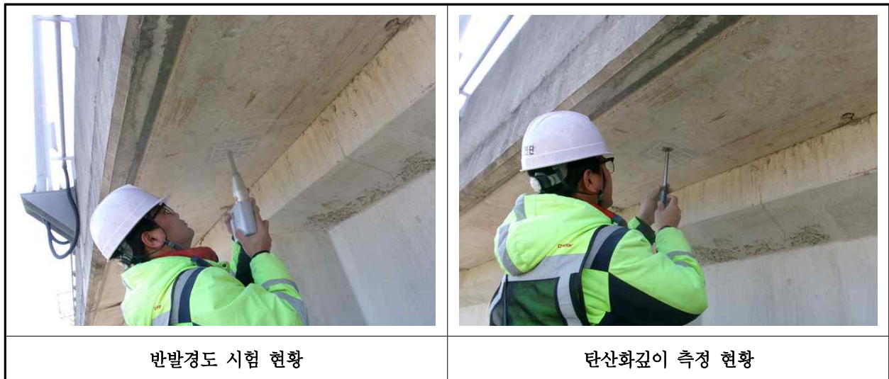
【사진 10.4.1】 콘크리트 내구성조사 현황
