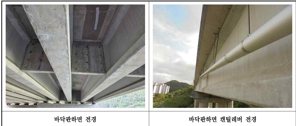
【사진 10.3.2】 바닥판하면 전경
