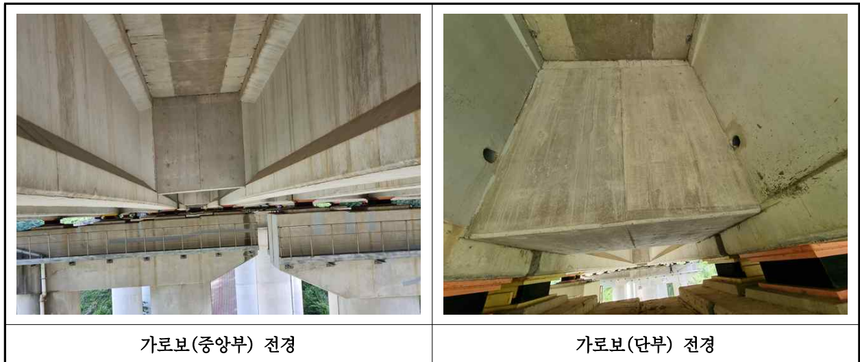
【사진 10.3.6】 가로보 전경
