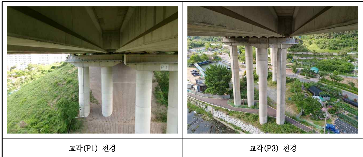
【사진 10.3.10】 교각 전경
