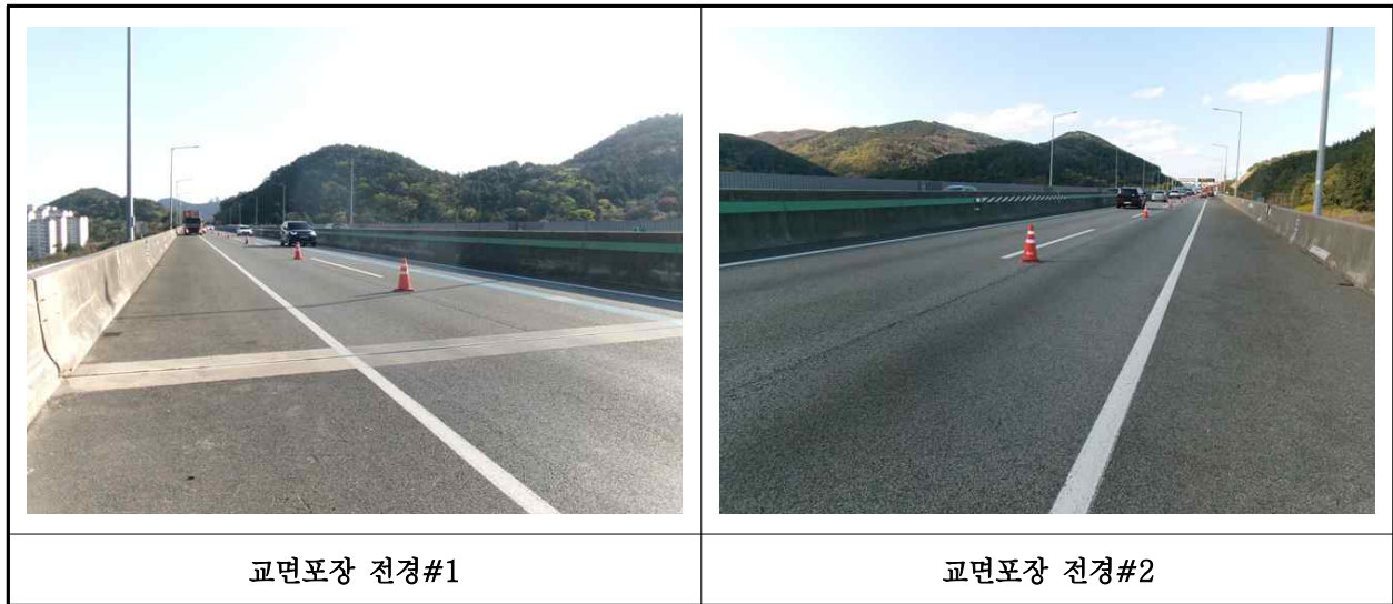
【사진 10.3.20】 교면포장 전경
