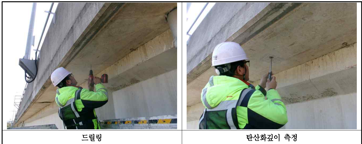
【사진 10.4.3】 탄산화 깊이 측정 현장사진
