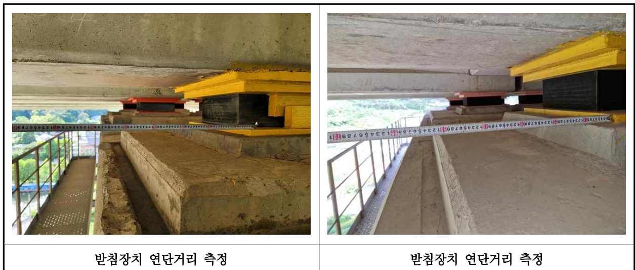
【사진 10.3.15】 교량받침장치 연단거리측정
