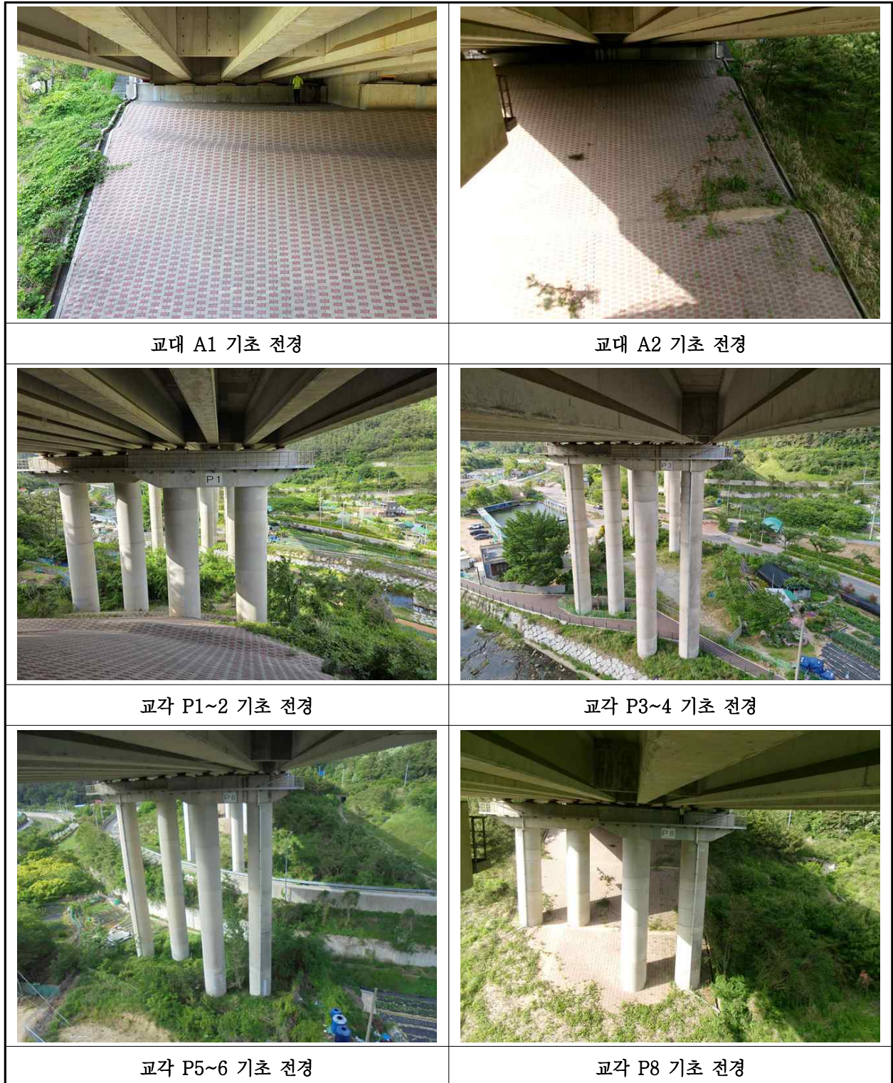
【사진 10.3.12】 기초 전경
