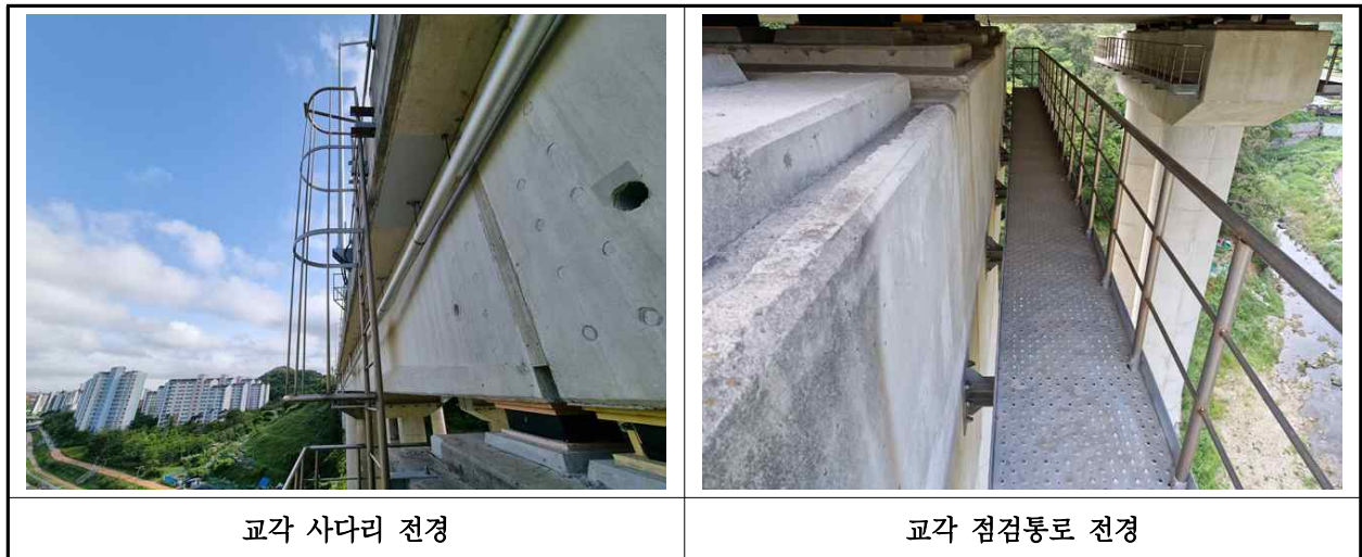
【사진 10.3.26】 교량 점검시설 전경
