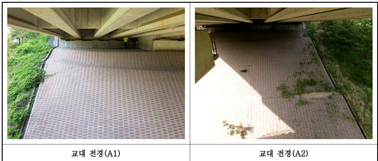
【사진 10.3.8】 교대 전경
