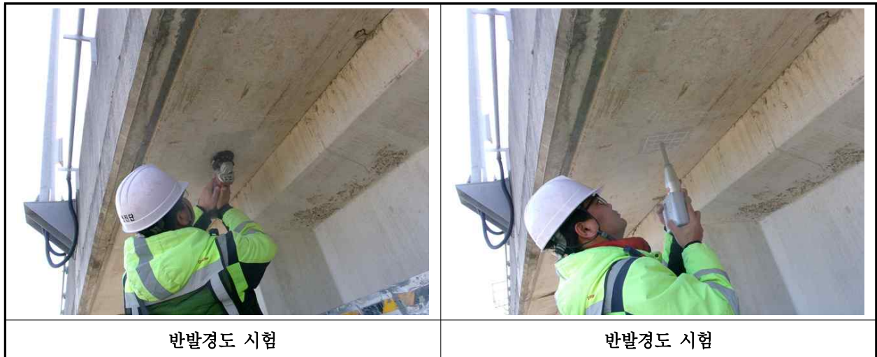
【사진 10.4.2】 반발경도시험 현장사진
